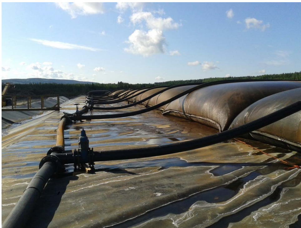
Kuva 4.4. Geotuubikenttä sakkojen varastointiin avolouhoksen vesienkäsittelyssä
