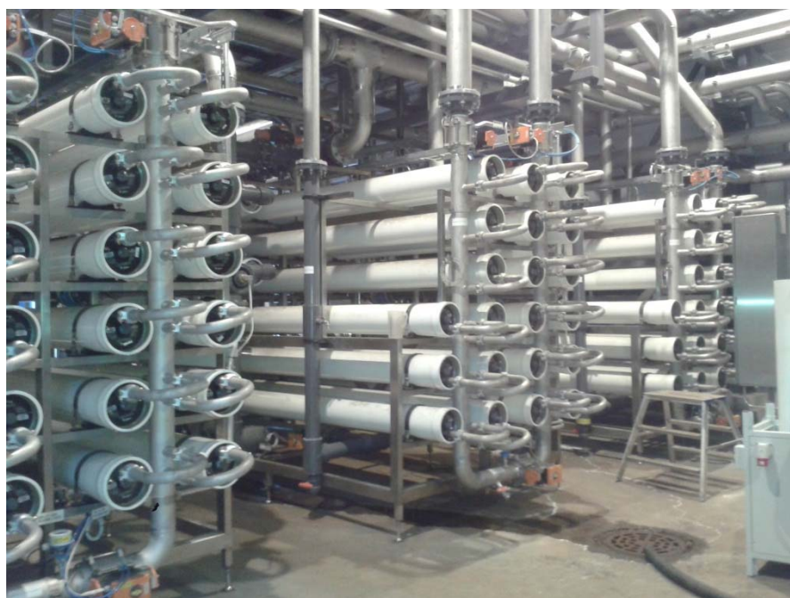
Kuva 4.2. RO-laitos vesilaitoksella
